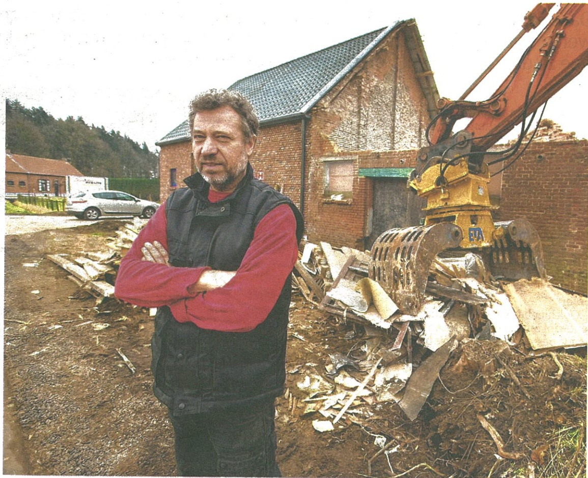
Guy Pirlot bij de hoeve in afbraak. In de zomer opent hier Proeverij Pirlot. FOTO JOREN DE WEERDT
